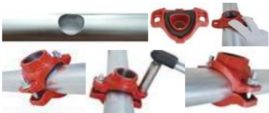
Рис.3. Установка отвода (седелка) под резьбу на трубопровод.
